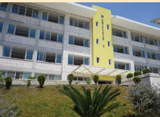
Das große Schul- und Schlafgebäude ist bereits voll belegt ...
